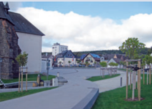
Neubau des Pfarrheims auf dem Hubertusplatz, Rathaus der Verbandsgemeinde, Zugang zum Hubertusplatz von Osten
