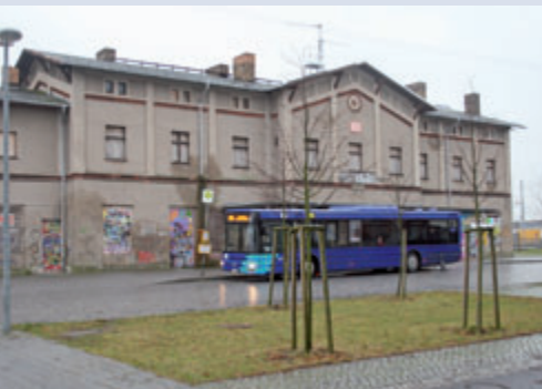
Geplanter Busbahnhof in Zehdenick, Bahnhofsgebäude in Fürstenberg und in Gransee (2013)
