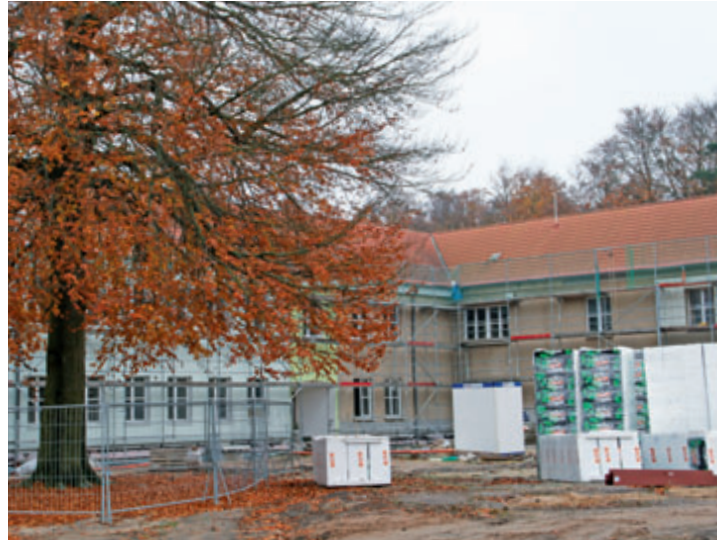
Die Grundschule in Heringsdorf, Mecklenburg-Vorpommern, wird umfassend saniert und umgebaut
