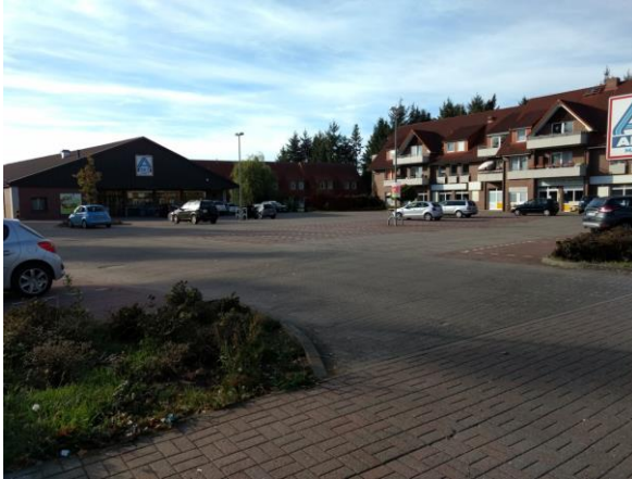
Abb. 5: Einfahrtssituation und Blick von Südosten auf das Plangebiet (Aufnahme Planungsbüro Patt, 9.10.18)
