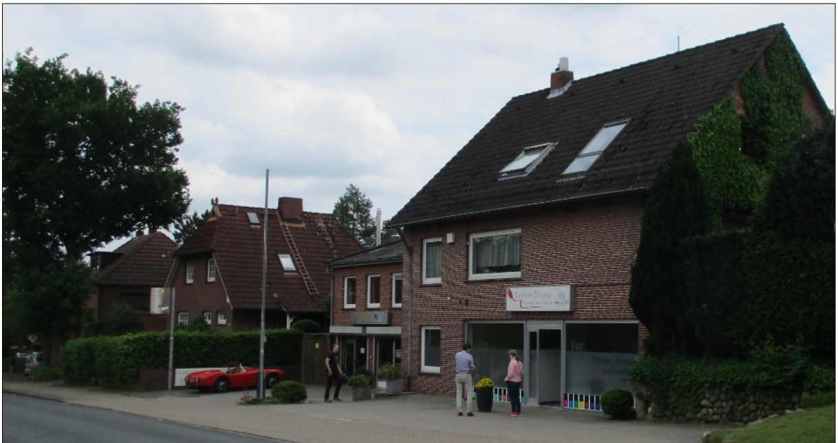
Abb. 5: Bestandsgebäude Buchholzer Str. 25/27, Blick aus Nordwest (Planungsbüro Patt, 8.6.2021)
