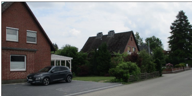
Abb. 8: Bestandsgebäude Bergstraße 1 und 3 (Planungsbüro Patt, 8.6.2021)
