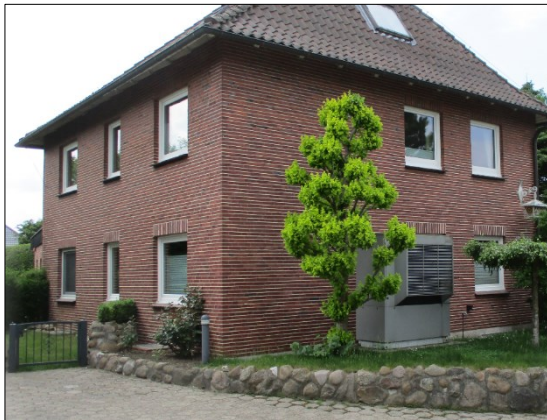
Abb. 6: Bestandsgebäude Meistergang 2 (Planungsbüro Patt, 8.6.2021)
