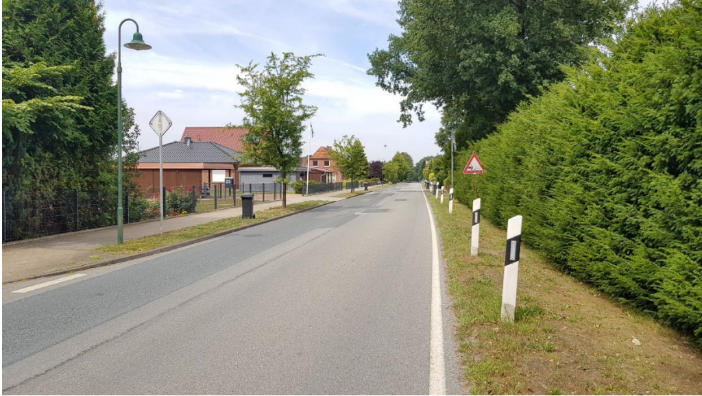
Blick in die Weseler Dorfstraße: Das Plangebiet liegt auf der linken Seite.
